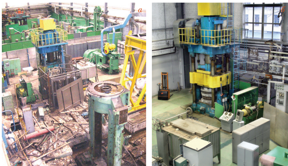
Реконструкция цеха изотермической штамповки: а — до реконструкции (2003 год); б — После реконструкции (2006 год)
