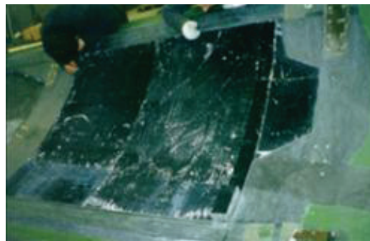
Восстановление сотового заполнителя в зоне разрушения
