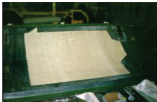
Восстановление толщины обшивки слоями стеклопластика
