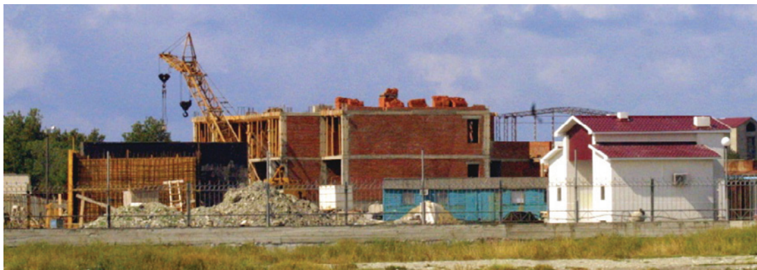
Строительство лабораторно-исследовательского корпуса Геленджикского центра климатических испытаний ВИАМ (2005 г.)
