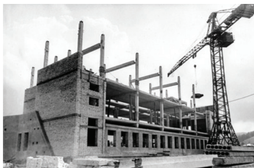
Строительство четырехэтажного лабораторного корпуса Батумского филиала ВИАМ (1974 г.)
