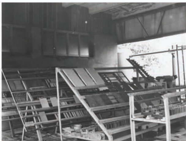
Испытания образцов под навесом на Батумском филиале ВИАМ
